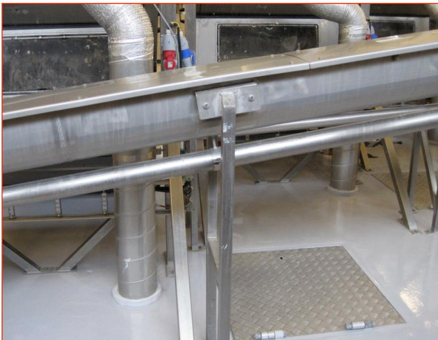
Mynd 14. Inni í skólphreinsistöðinni. Grisjuvöndlarnir voru látnir ofan í þró sem er undir hlera á gólfínú þar sem skólpið rann í gegn eftir grófsíun.
