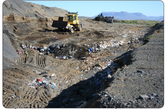
Mynd 1b. Yfirborðspekja sett yfir úrgang.
